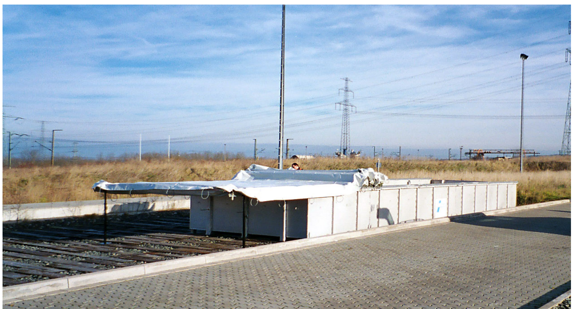
Bild 8 Güterverteilzentrum Erfurt - Vieselbach
