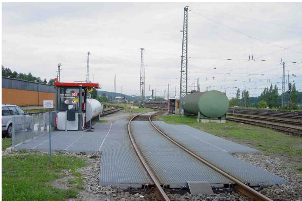
Bild 8 Tankanlage im Gleisbogenbereich
