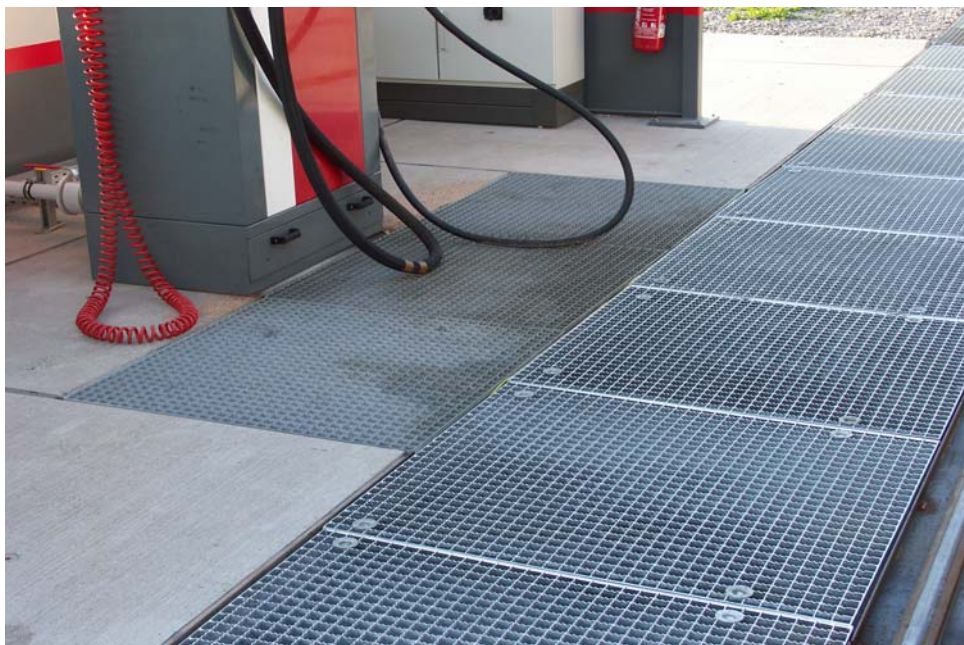
Bild 10 Gitterrostausbildung im Bedienstegbereich
