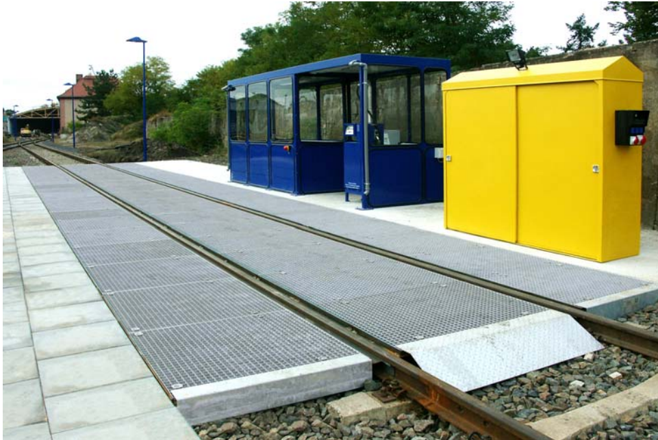
Bild 9 Tankanlage und Vakuum - WC - Entsorgung
