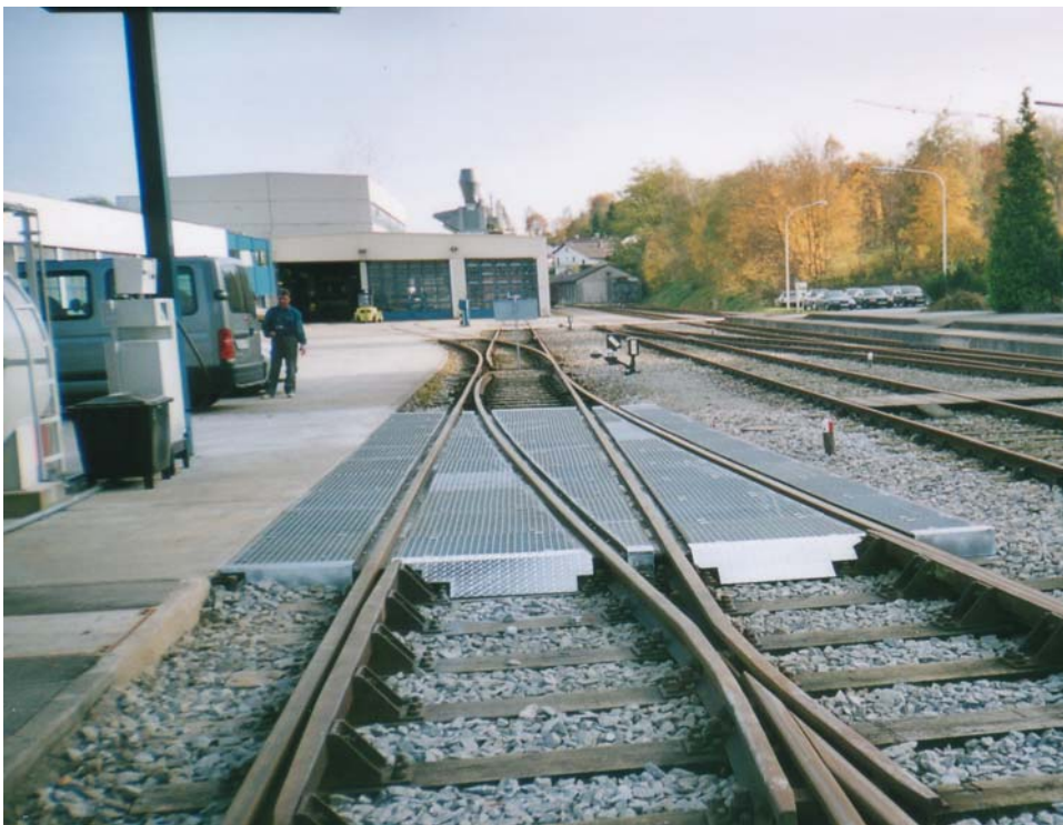
Bild 6 Tankanlage im Weichenbereich
