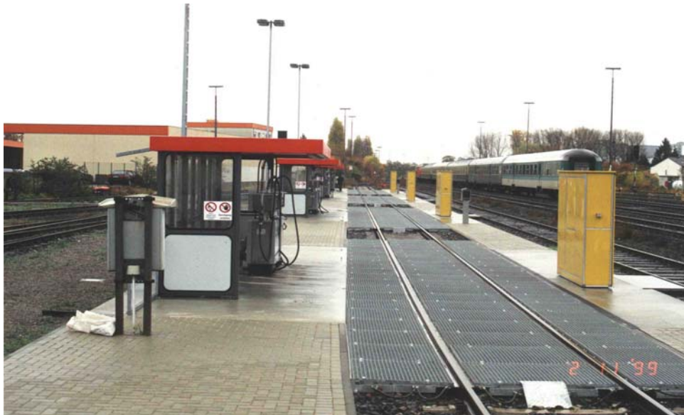
Bild 7 Tankanlage für Triebzüge, 4 Betankungsstände
