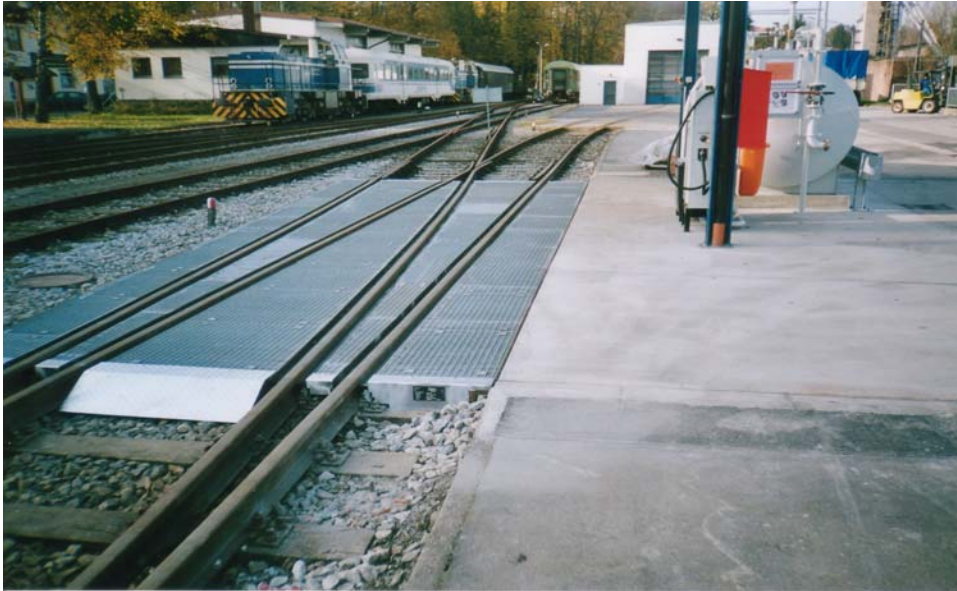
Bild 5 Tankanlage im Weichenbereich
