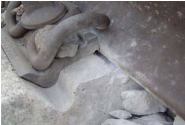
Bild 8: Betonschwelle mit verringerter Nutzungsdauer wegen nicht rechtzeitig erfolgten Zwischenlagentauschs
