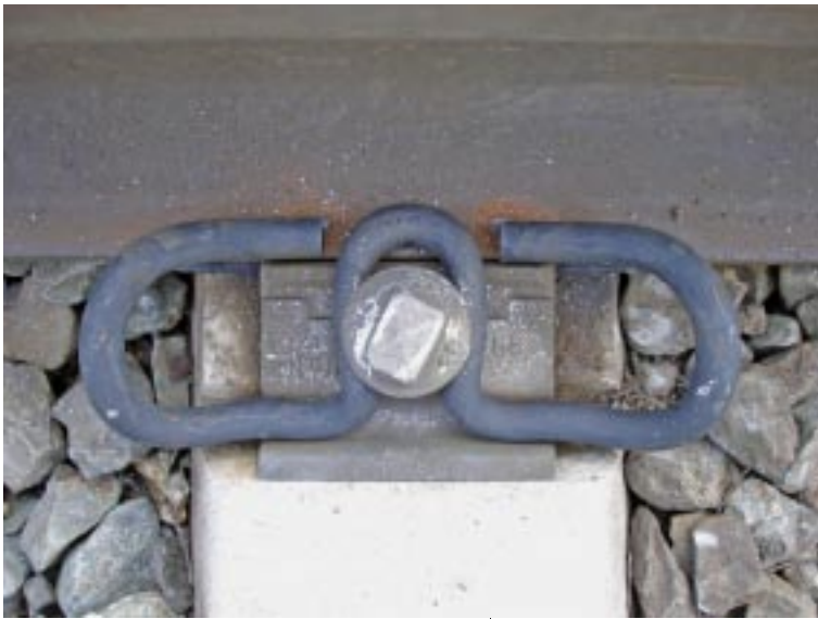
Bild 2: Spannklemme Skl 28 für enge Bögen mit R < 600 m
