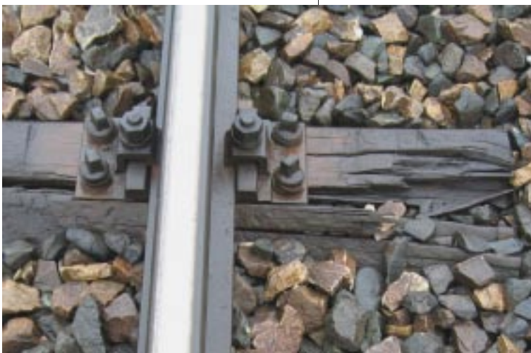
Bild 3: Holzschwelle mit Alterungserscheinungen
