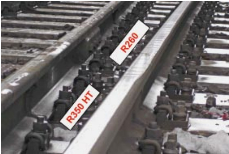
Bild 6: Schlupfwellenbildung an zwei Bogenschienen mit unterschiedlicher Stahlgüte
