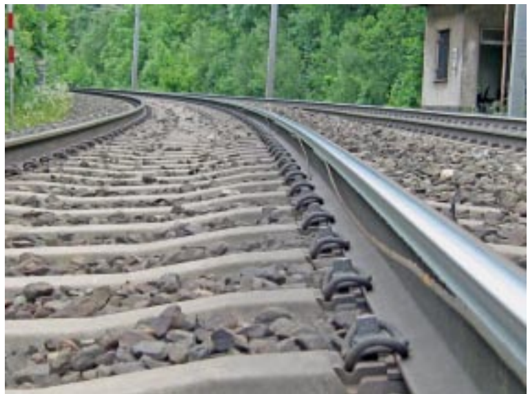
Bild 1: Enger Bogen mit kopfgehärteten Schienen zur Minderung des Seitenverschleißes und der Schlupfwellen
