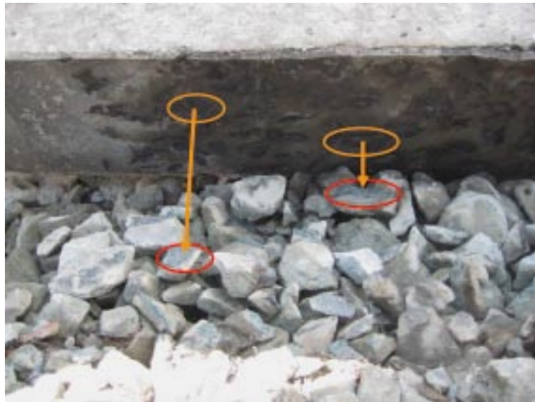
Bild 15: Schonung des Schotterbetts durch Schwellenbesohlung
