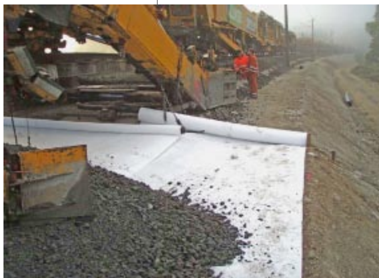
Bild 5: Maschineller Einbau einer Tragschicht mit Geotextil
